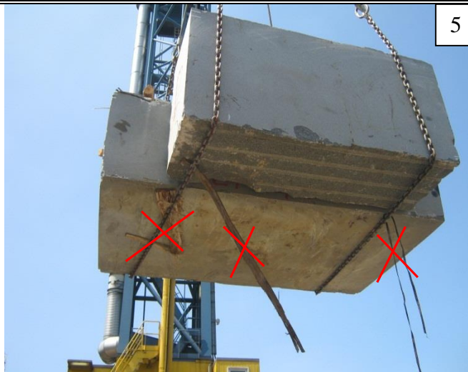
Overdraaien geklemde balken en lashingmateriaal dat onder blokken hang
