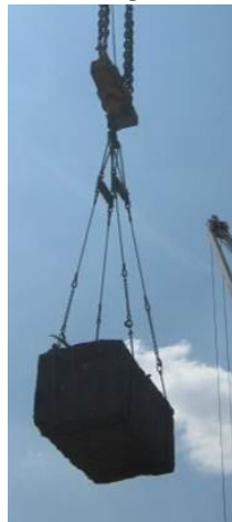
Ketting rond scherpe rand Gewicht van de granietblok = 14 ton
