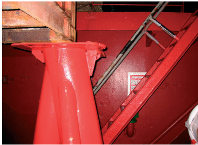
Support waar de kuiper vanaf viel.
