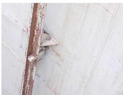
Stopper waarop luikdeksel rust
