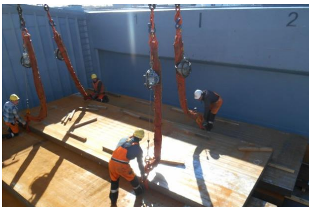
Foto1: gebruik plaatpannen zonder doorloopketting.
