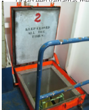
Opgelet voor open mangaten.
