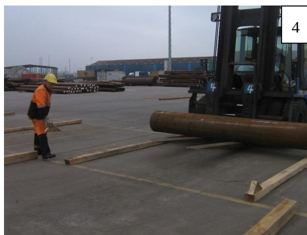
Kallen aan achterzijde bedding
